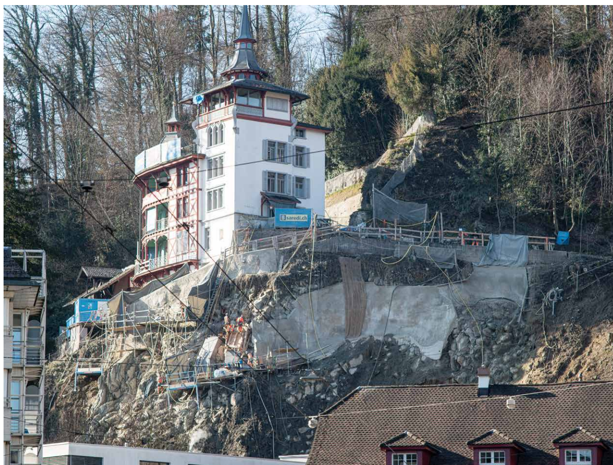
Sicherungsmassnahmen Gütschhang Luzern
